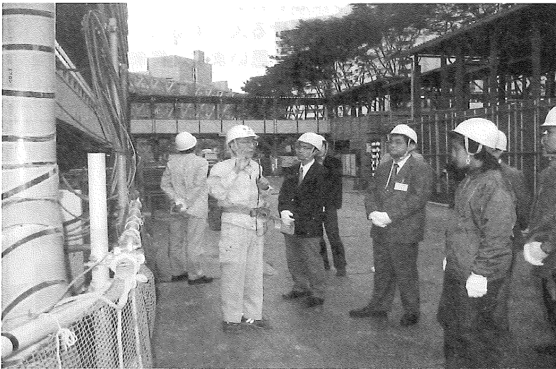
施工現場で熱心に説明 を聞く参加者
