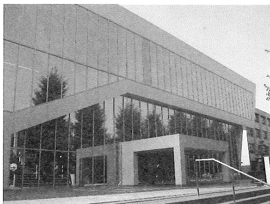
写真1 カナル会館 正面
