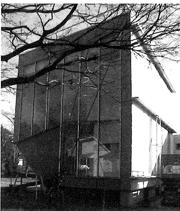
光触媒実験棟(北・西面)
