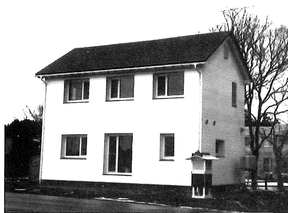
長万部超高断熱実験棟
