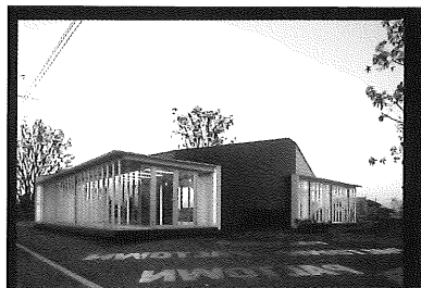
群馬県太田市の「バルタウン城西の杜」は、40haあまりの敷地を戸建て住宅地として設計するコンペで小嶋研が指名されて当選。この「集会場」は成果の一部で学生たちで設計・監理を行った。(写真:上田宏)
